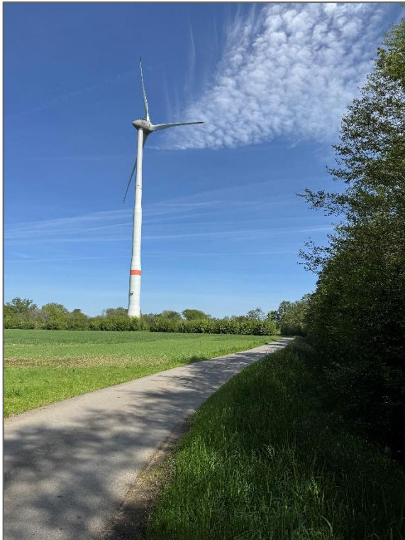
Abb. 2-4: WEA in der nördlichen Umgebung des Vorhabenbereichs
